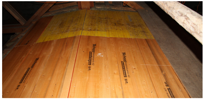
Abb. 12: Mit Schalungsbrettern ausgekleideter Dachbodenbereich unter der Wärmeglocke, Kapelle Totengut. Foto: Erich Mühlethaler
