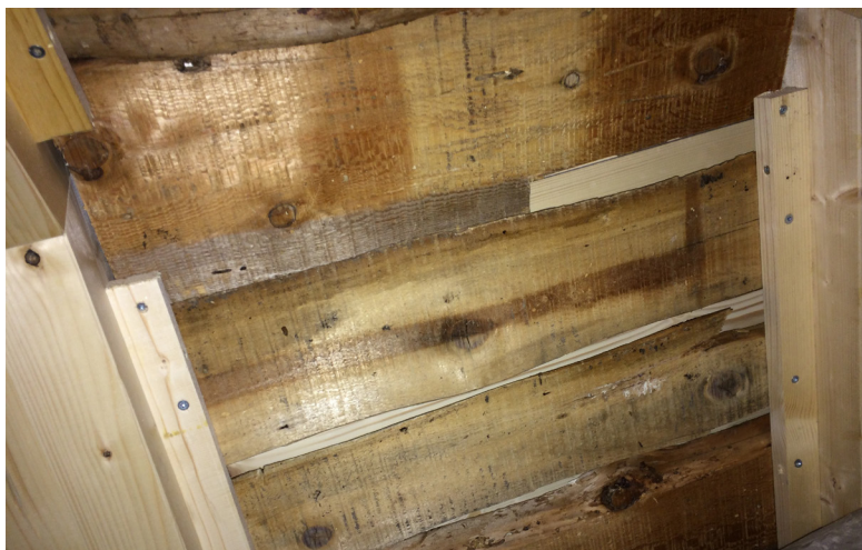
Abb. 17: Innenansicht des neuen Quartiers mit eingebauten alten Brettern, Surselva. Foto: Gebäudeeigentümer
