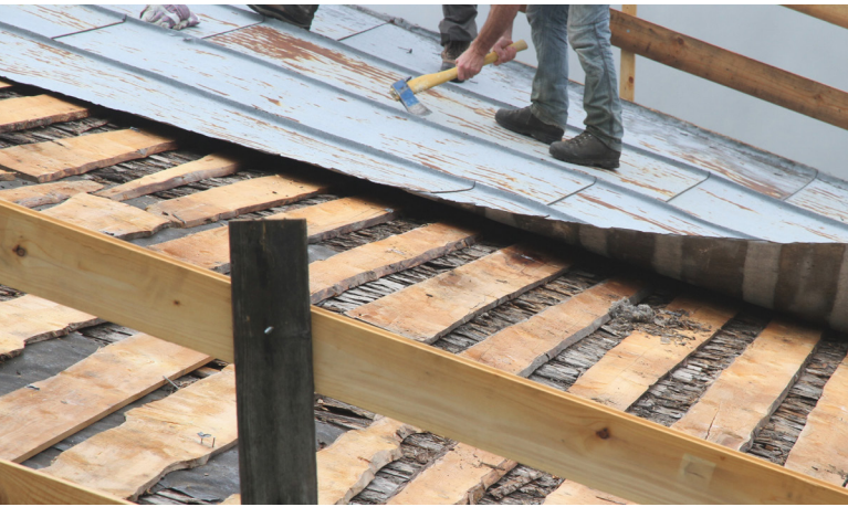
Abb. 14: Entfernung des alten, undichten Blechdachs, Surselva. Foto: Erich Mühlethaler
